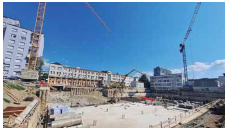
IZGRADNJA PRIZIDKA ZDRAVSTVENEGA DOMA V NOVI GORICI
