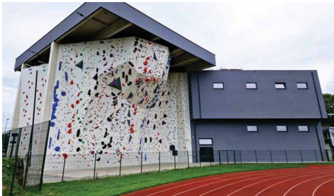
ZAKLJUČENA ZUNANJA PLEZALNA STENA PLEZALNEGA CENTRA SLOEVNSKA BISTRICA VIŠINE 17 M.
