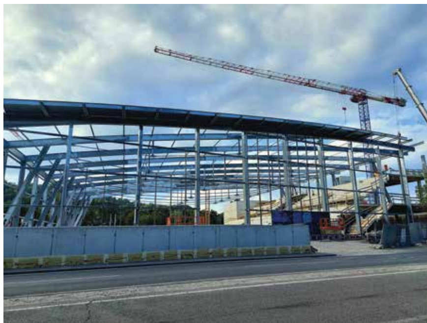
MONTAŽA JEKLENE KONSTRUKCIJE NA GRADBIŠČU ŠPORTNEGA CENTRA ILIRIJA
