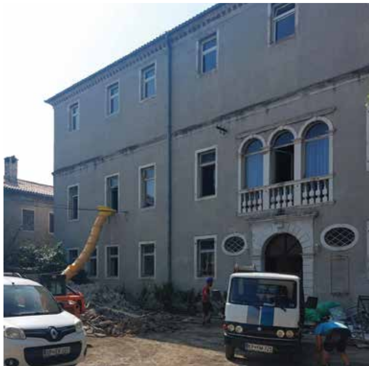
RUŠITVENA DELA NA COLLEGIU DEI NOBILI
