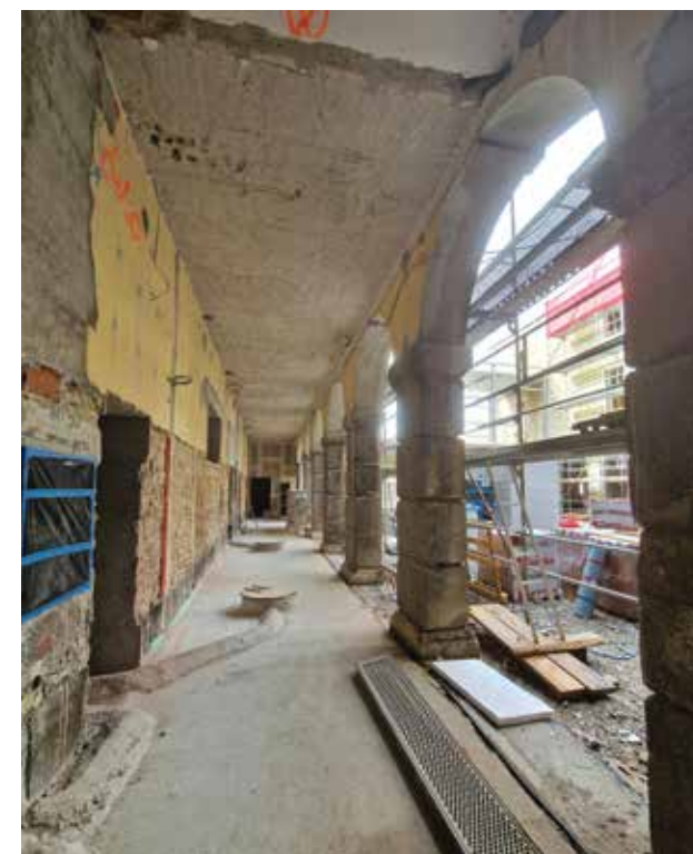
PO CELOTNEM OBJEKTU SE JE IZVEDLA NOVA INTERNA KANALIZACIJA
