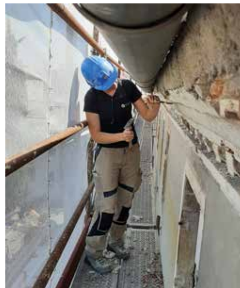
RESTAVRATORSKA DELA NA NAPUŠČNEM VENCU. FOTO: GNOM D.O.O
