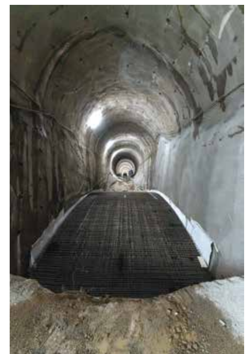
V ŠESTKILOMETRSKIH PREDORIH, VEČ STO METROV POD ZEMLJO, SE GRADIJO PREMOSITIVNE KONSTRUKCIJE ČEZ NAJVEČJE KRAŠKE JAME.
